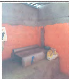
Foto 5: REMODELACION DE COCINA.
