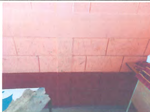
Foto 2: PINTURA EN AULAS, INTERIOR Y EXTERIOR.
